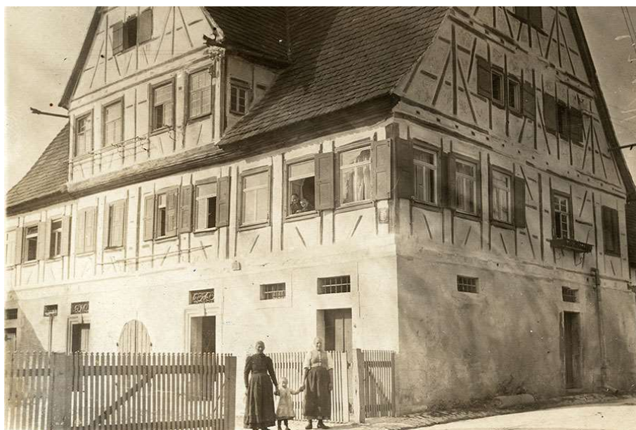
26. ábra: A Bühler család lakóháza Öschelbronnban 1911-ben 12
